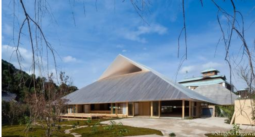
直島ホール 所有者：直島町 設計：三分一博志建築設計事務所
